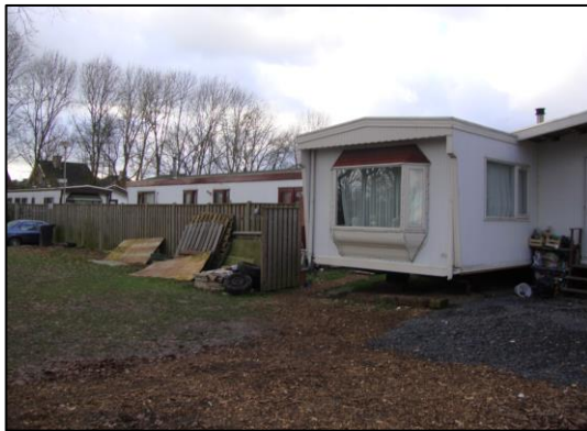
Schutting in slechte staat
