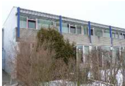
Hotelgedeelte gezien vanaf de oost- en achterzijde
