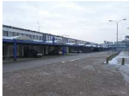
Hotelgedeelte, parkeerplaatsen en overige verharding gezien vanaf de noord- en voorzijde
