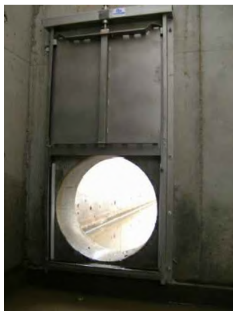
PRINCIPE SPINDELSCHUIF
