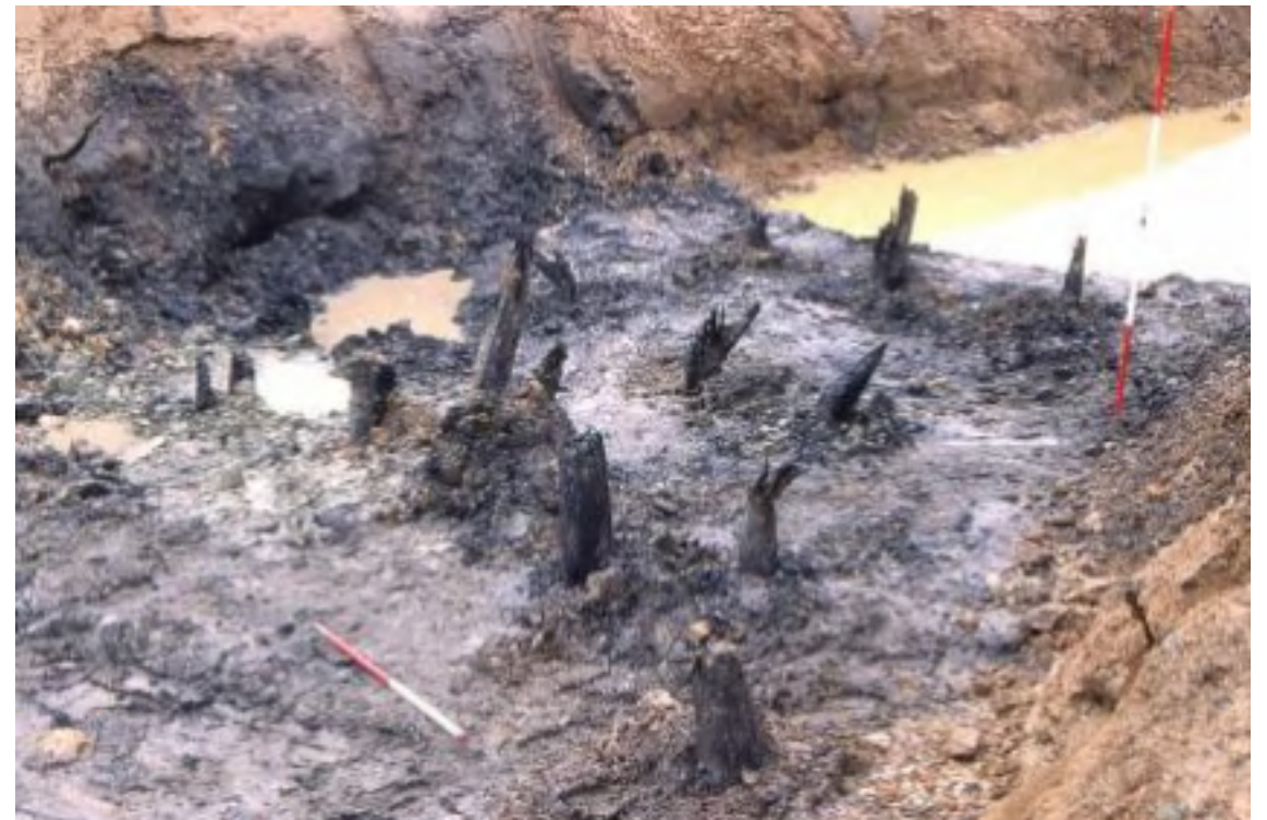
Figuur 73. Vermoedelijk zijn dit de ingeheide funderingspalen van het laat-middeleeuwse molengebouw van de Busschopsmolen (bron: Vromans, 2007).
