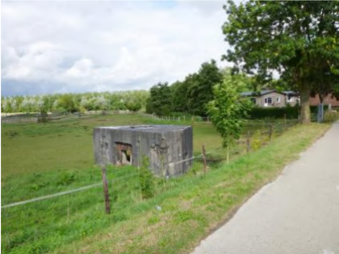
Figuur 32. De bunker uit de Tweede Wereldoorlog langs de noordzijde van de Brommelderweg.
