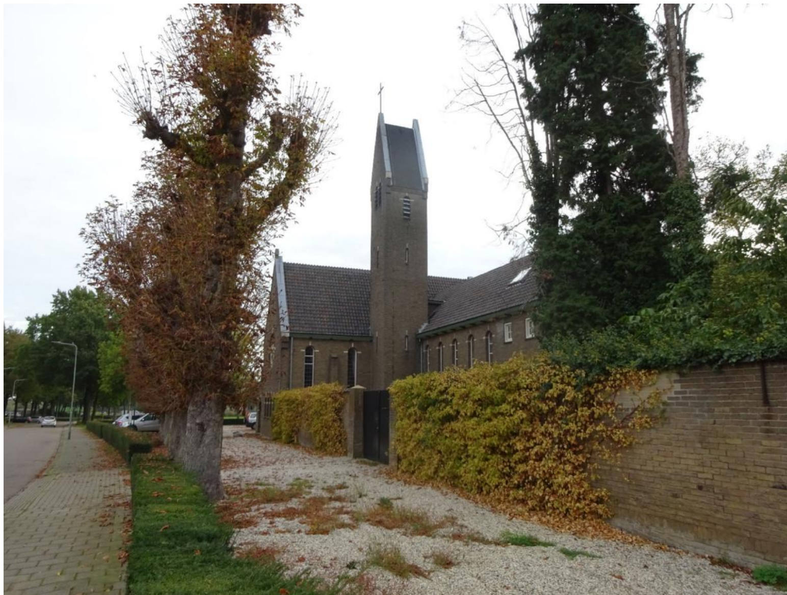
Figuur 21 -Voorgevel en gedeelte kloostermuur met poort; links de gekandelaberde kastanjabomen.
