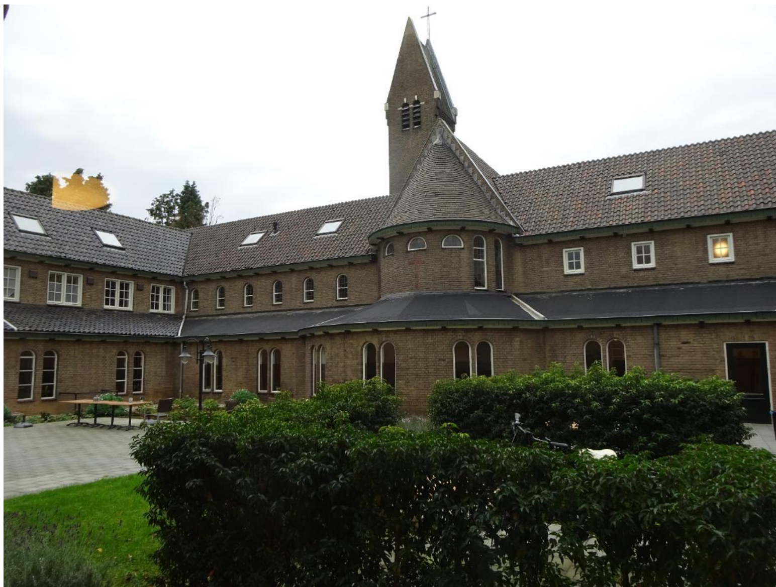
Figuur 23 - De binnengevels van de carré.
